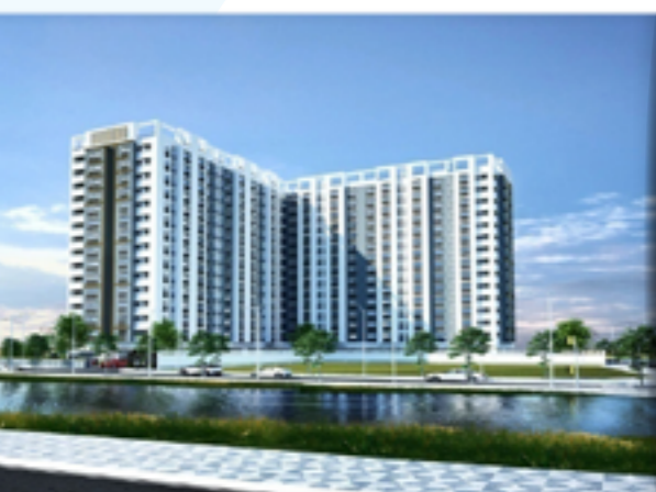
Chung cư An Phú Đông, quận 12 (SGR)
